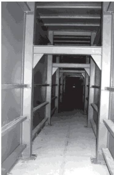
Hauptluftkanal bis 5,0 m hoch siehe Seite 54 Trapezwände
